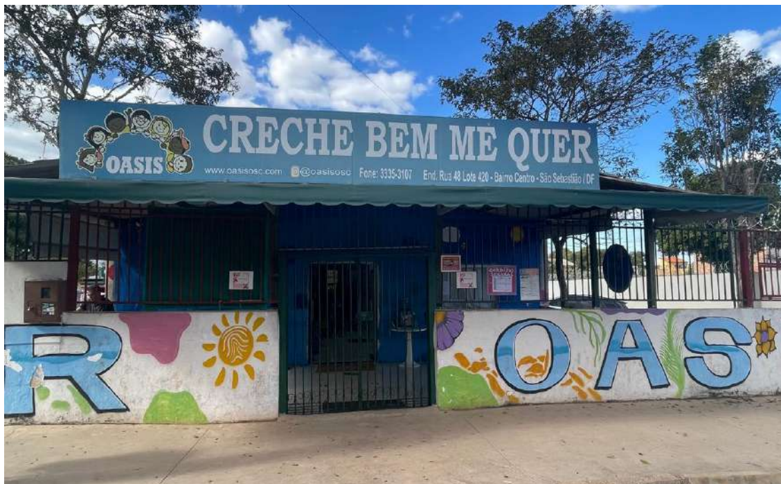
Fachada da instituição
