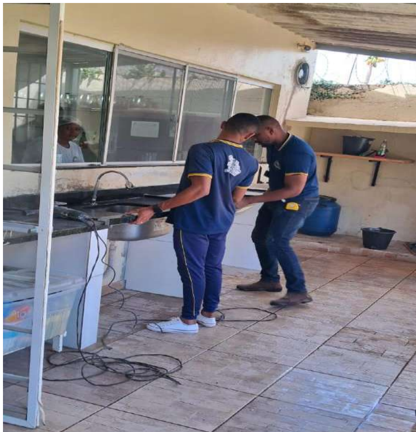
Instalação de soleira na pia da cozinha da parte externa
