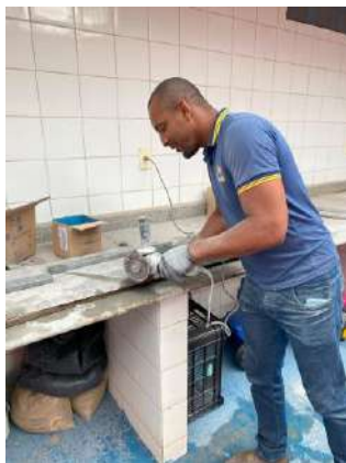
Aplicação de mármore nos banheiros
