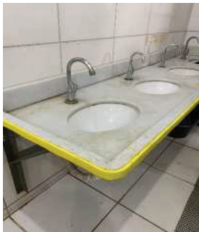
Emborrachado nas quinças das escadas e pias - fotografia
